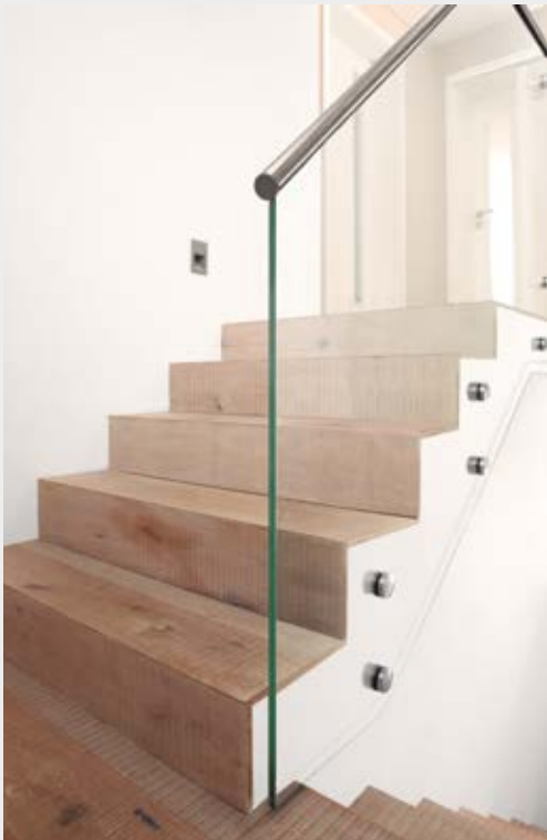
celoskleněné zábradlí, nerezové madlo, kotvení puky
